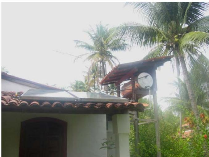
**FIG. III. 45 – Painéis Solares em Empreendimento Turístico para Aquecimento da Água**
